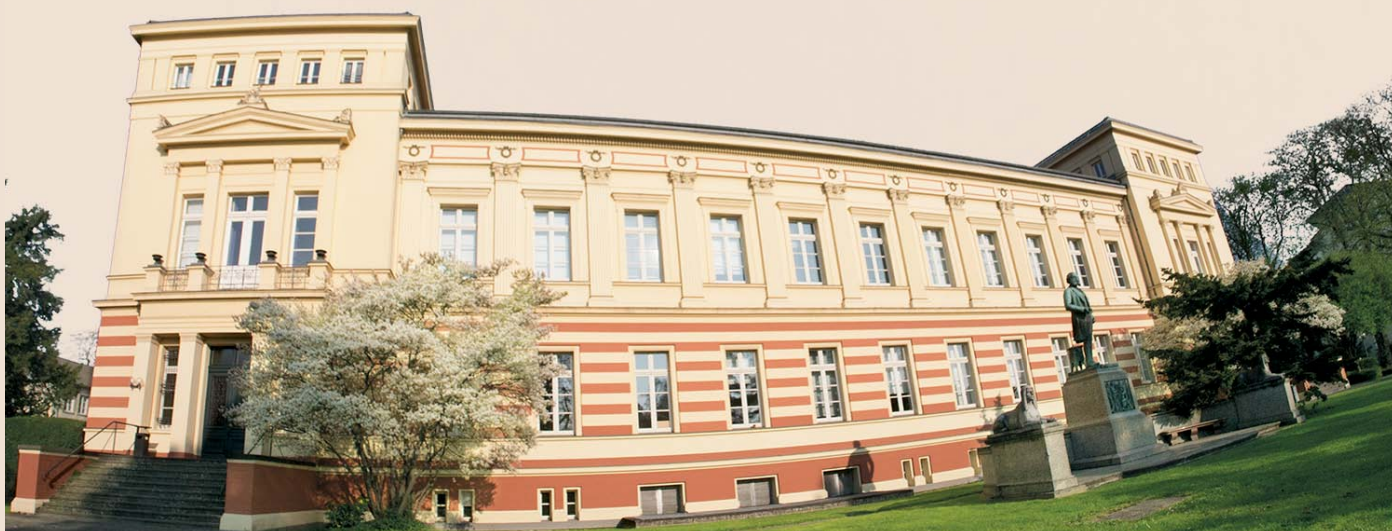
Das Alte Chemische Institut mit dem Kekulé-Denkmal, 2014
