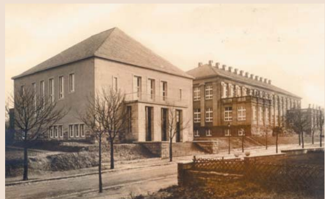
Das Hörsaalgebäude an der Nordseite des Instituts im Jahr 1929 (Postkarte, Sammlung U.-B. Richter).
